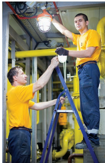
Рабочие монтируют БКК
