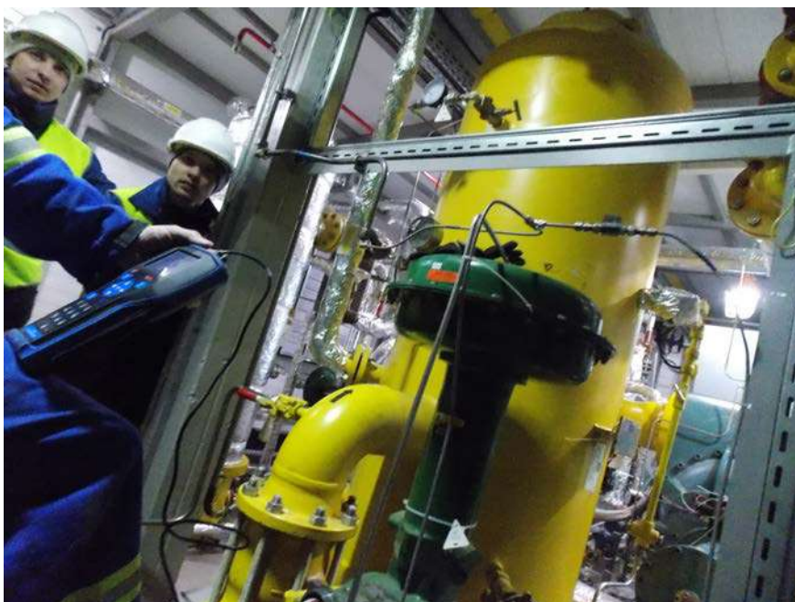
Пуско-наладочные работы станции для РН-Уватнефтегаз
