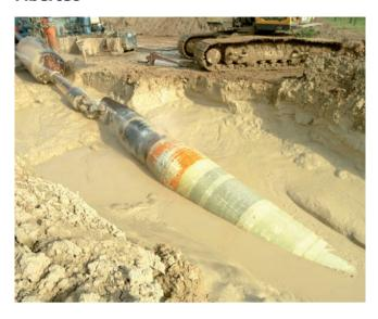
Fibertec является устойчивой, готовой к монтажу предламинированной композиционной пластмассой, армированной стекловолокном. Он обеспечивает оптимальную механическую защиту для гидроизоляционного слоя труб и абсолютно водонепроницаем. За счет легкой усадки материала Fibertec держится почти на всех поверхностях, таких как: металл, полиэтилен, полипропилен, каменнокерамические изделия, стеклопластик и бетон.
