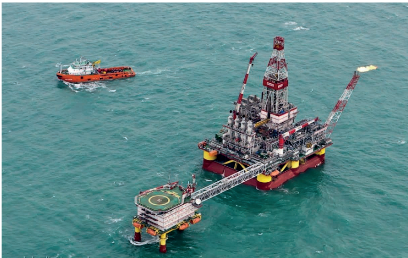
Рис. 5. Общий вид морской платформы на месторождении им. Ю. Корчагина в северной части Каспийского моря с взлетно-посадочной площадкой, оборудованной РУПТ
