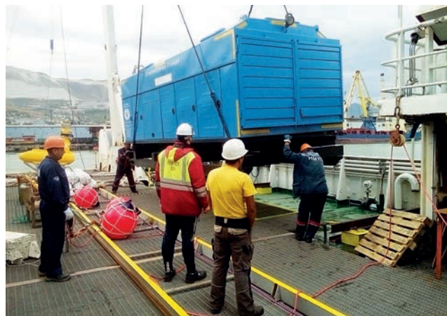
Установка арендованной азотной станции ТГА-10/251 на палубе морского судна
