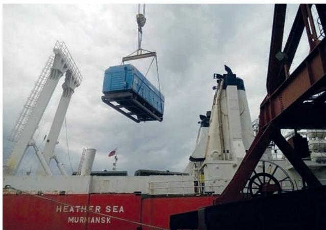
Погрузка арендованной азотной станции ТГА-10/251 в порту на борт морского судна
