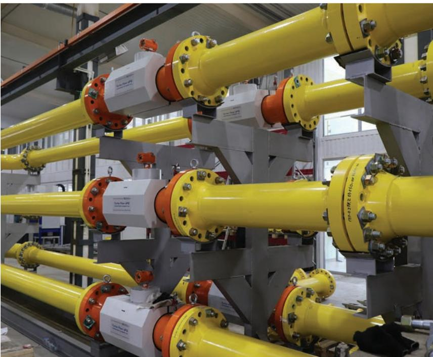
Рис. 8. Расходомеры Turbo Flow UFG с повторяемостью 0,1% (Dn400, Dn250, Dn100)
