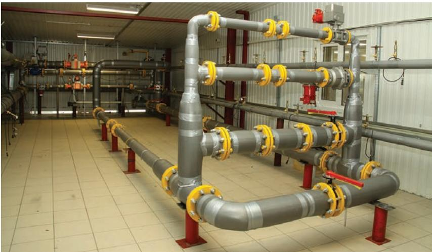
Рис. 3. Эталонная испытательная мультигазовая установка СПУ-МГ-4М, производства ООО НПО «Турбулентность-ДОН»
