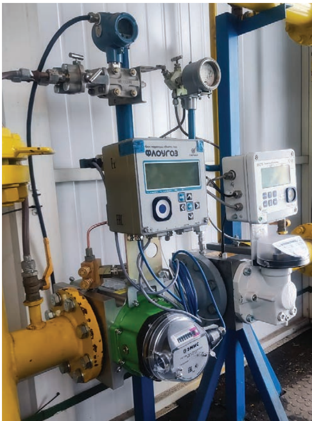
Ротационный счетчик газа ЭМИС-РГС 245 в составе комплекса учета на объекте ООО «Газпром межрегионгаз»
