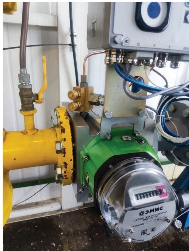
Ротационный счетчик газа ЭМИС-РГС 245 в составе комплекса учета на объекте ООО «Газпром межрегионгаз»
