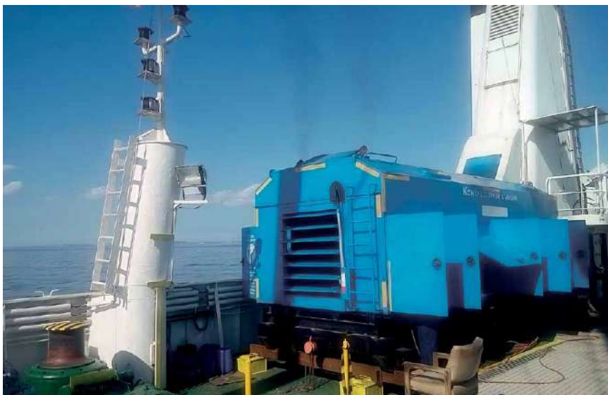
Компрессорная станция ТГА на судне
