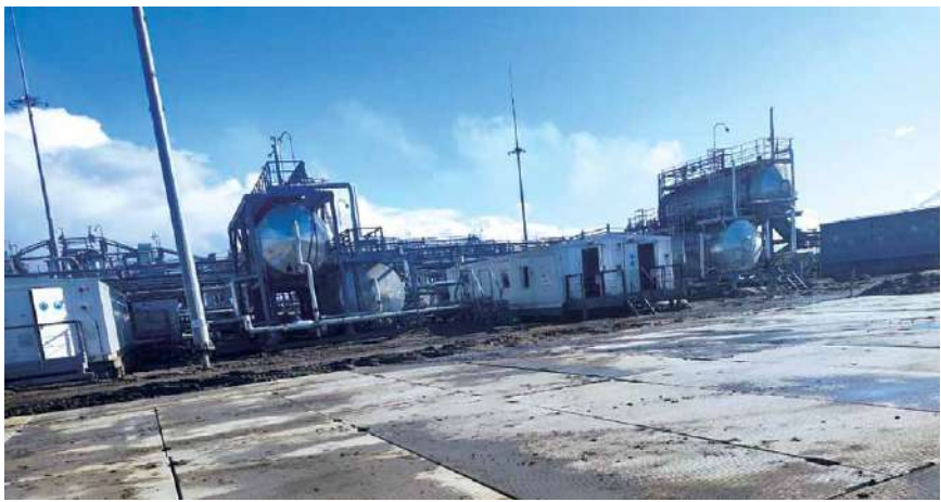
Рис. 6. Фото плитного основания на объекте
