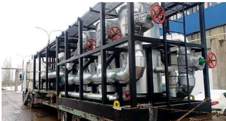
Рис. 5. Фото крепления блока на прицепе для транспортировки на объект
