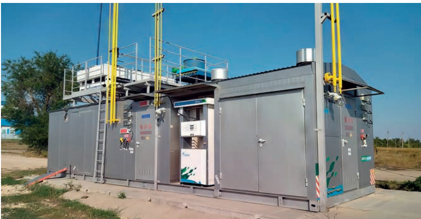
Фото 3. Компрессорный модуль стационарной АГНКС, смонтированный на объекте у предприятия-заказчика ПАО «Газпром автоматизация», ООО «Завод «Саратовгазавтоматика»
