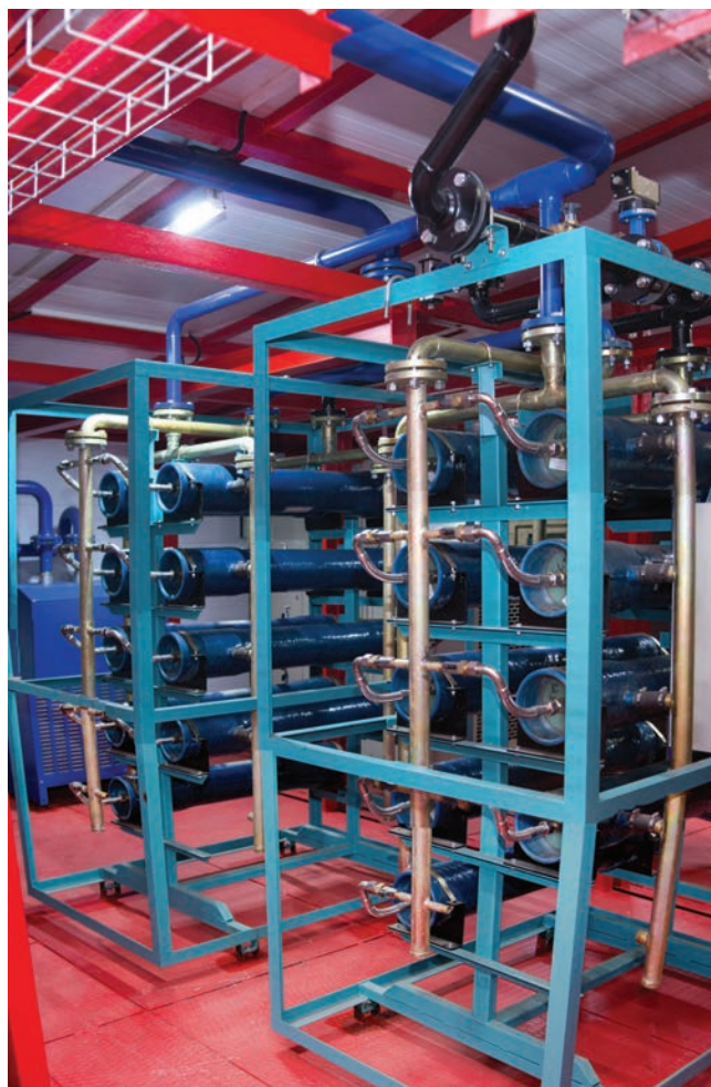
Азотные станции ЧКЗ
