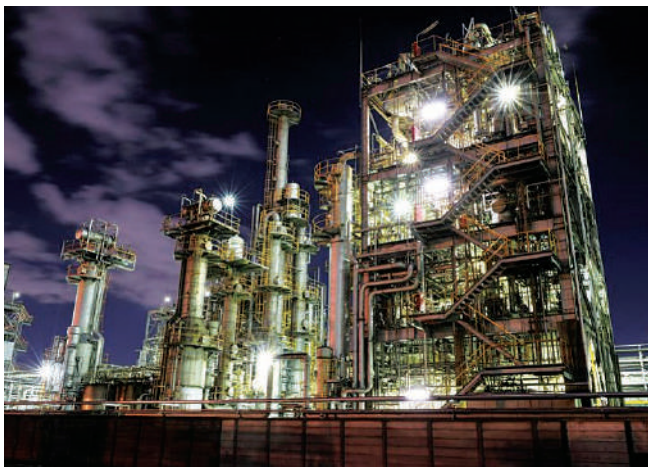
Рис. 3. Объект применения решетчатых настилов – газоперерабатывающий завод
