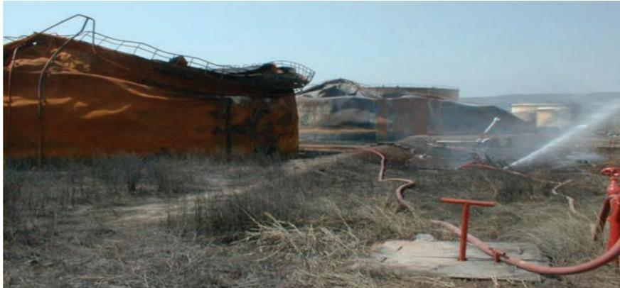
1999 г. Измитское землетрясение ( $M=7.4$ ), Турция, вызвало пожар и затем разрушение резервуаров (перерабатывающий завод в Yarimca)
