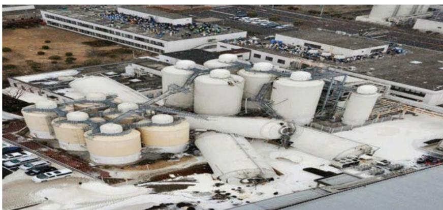
Землетрясение в Коста-Рика 1991 года ( $Mw=7.8$ ) вызвало опрокидывание баков и разлив опасной жидкости
