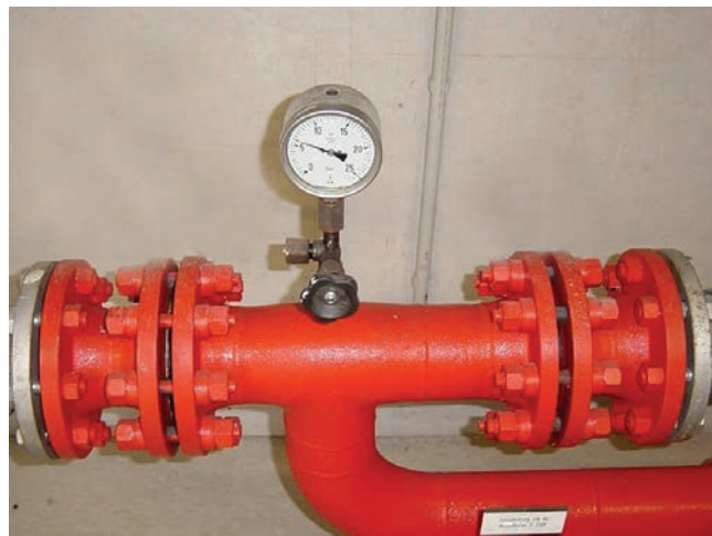
Рис. 2. Изолирующее фланцевое соединение
