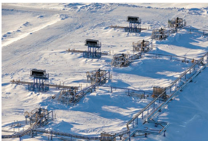
Рис. 3. Площадки кустов газовых скважин с системами температурной стабилизации грунтов «ВЕТ». Бованенковское НГКМ
