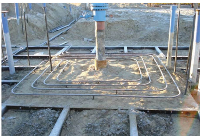
Рис. 2. Система температурной стабилизации грунтов «ВЕТ» на опорной раме
