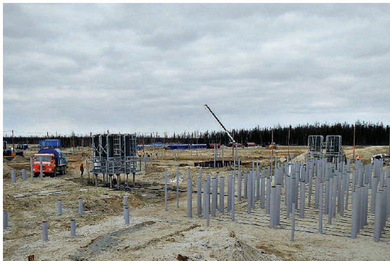
Смонтированные системы охлаждения, готовые к засыпке
