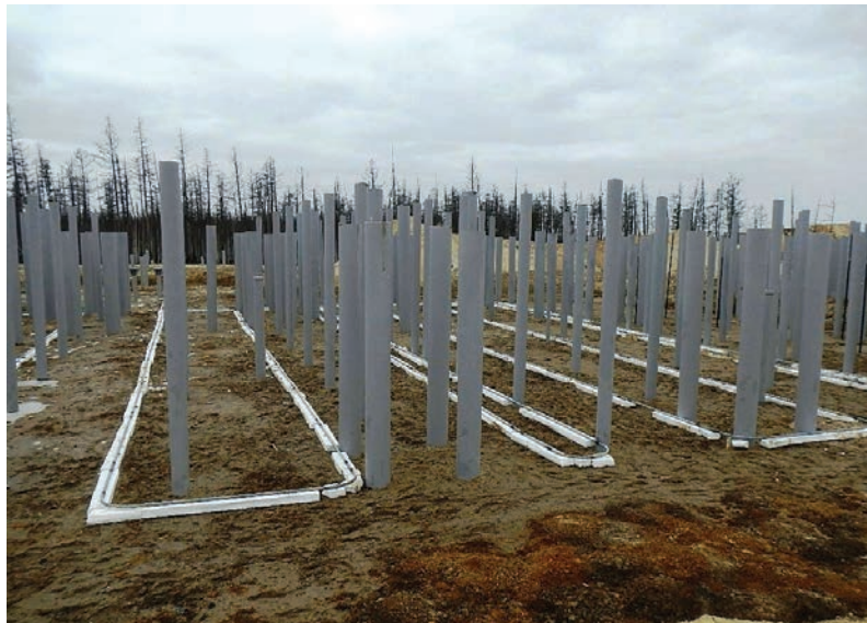
Противопучинные меры-укладка пенополистирола под соединительные трубы системы ВЕТ
