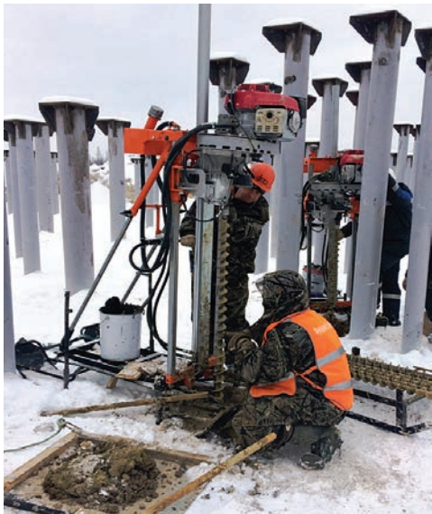
Бурение скважин под вертикальные охлаждающие трубы
