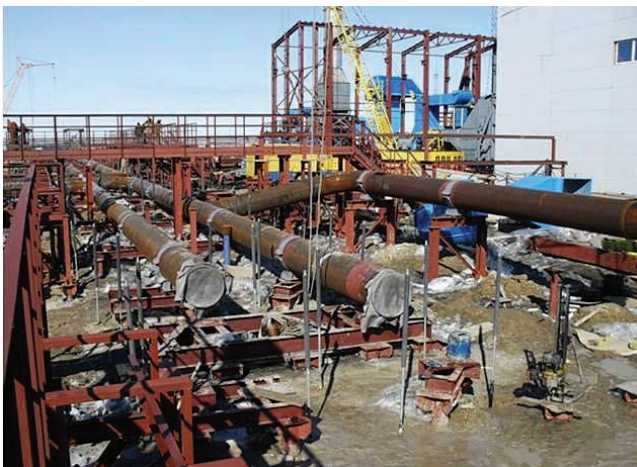
Рис. 4. Обвязка ГПА ДКС с использованием индивидуальных термостабилизаторов
