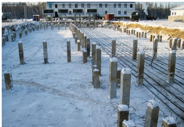
Рис. 7. Особенность систем «ГЕТ» и «ВЕТ» – конденсаторная часть отдалена от подземных охлаждающих труб
