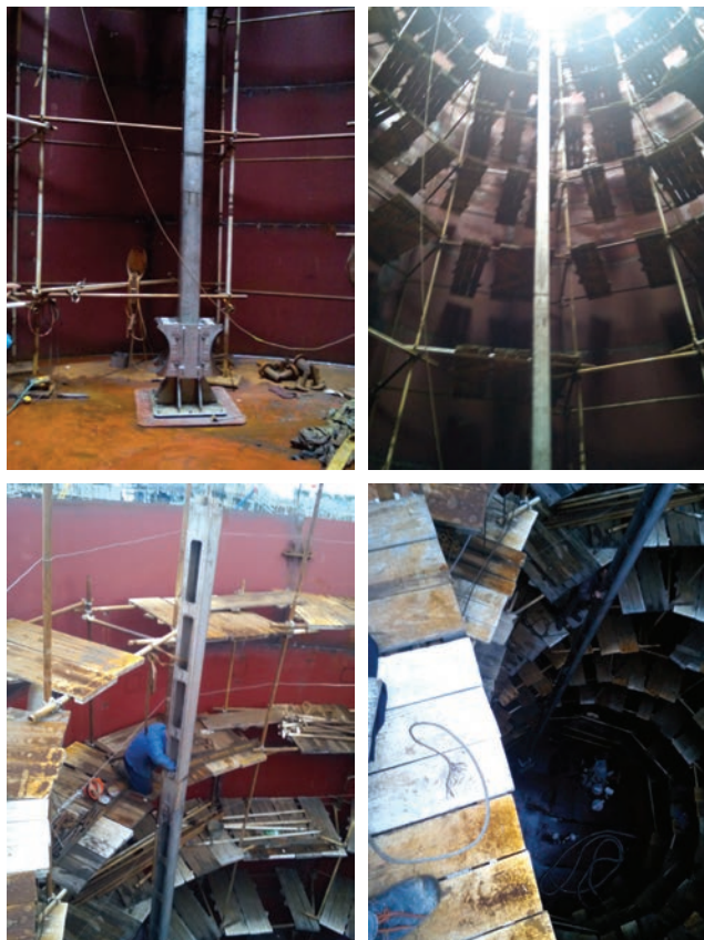
Монтаж направляющей для понтонного скиммера
