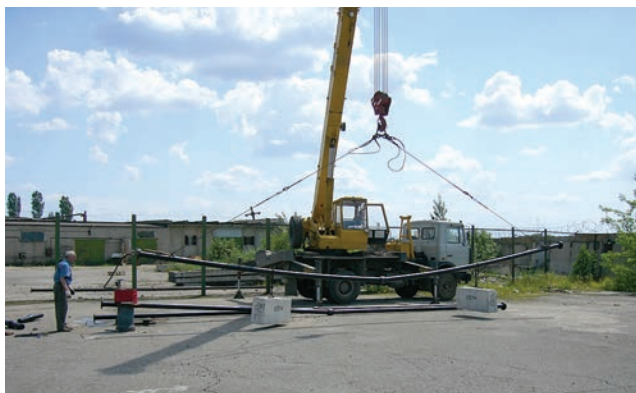
Рис. 4. Испытания плети с соединением «RJ» на внутреннее давление с изгибом
