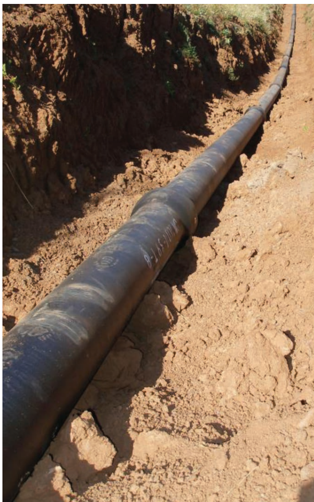
Рис. 8. Трубопровод Ду 200 мм, смонтированный из труб ВЧШГ с применением соединений типа «RJ»
