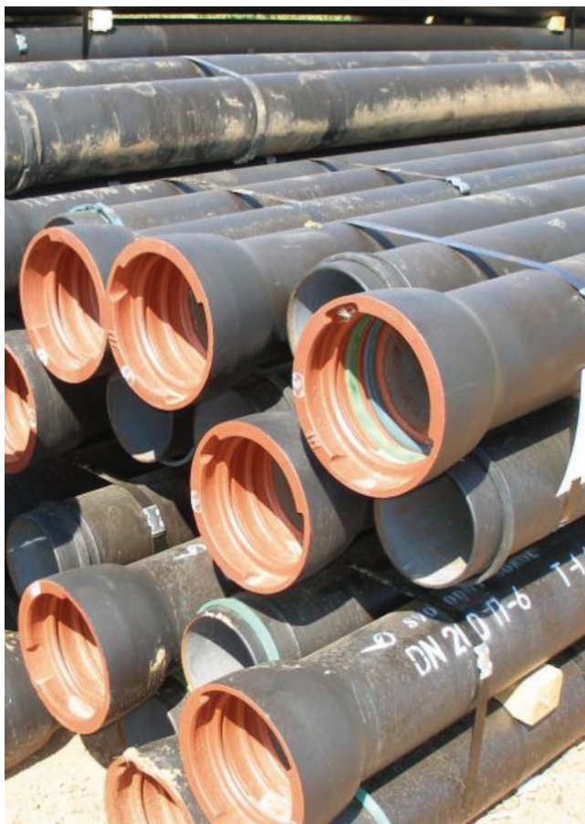
Рис. 7. Партия труб из ВЧШГ под соединения типа «RJ», подготовленная к монтажу трубопровода
