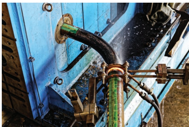
Гнутье трубы с использованием технологии индукционного нагрева
