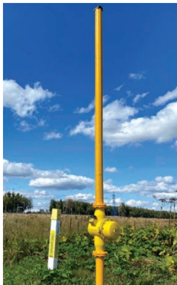
Рис. 8. КП ТМ контроля загазованности перехода, установленный на вытяжной свече
