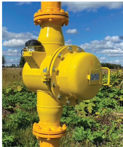
Рис. 8. КП ТМ контроля загазованности перехода, установленный на вытяжной свече
