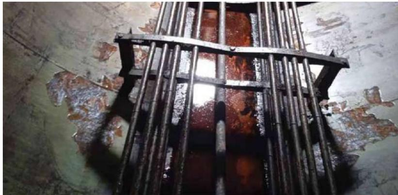
Рис. 8. Фото поверхности металла технологической емкости 100 м³ до ремонтного воздействия
