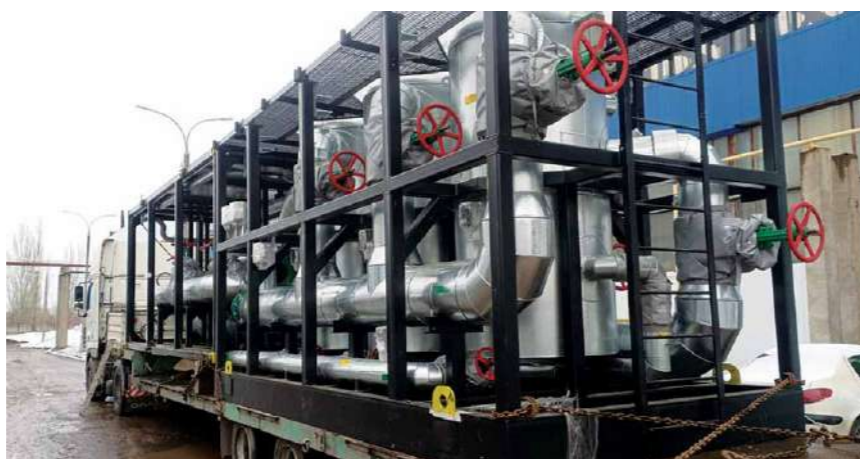
Рис. 5. Фото крепления блока на прицепе для транспортировки на объект
