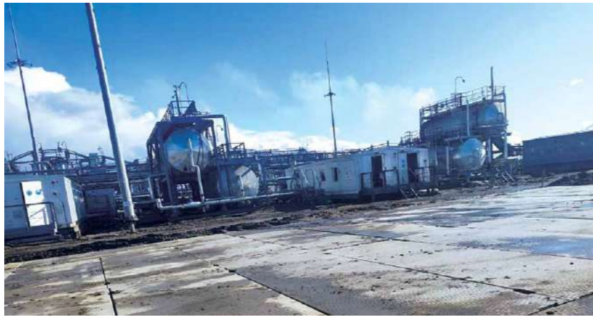
Рис. 6. Фото плитного основания на объекте
