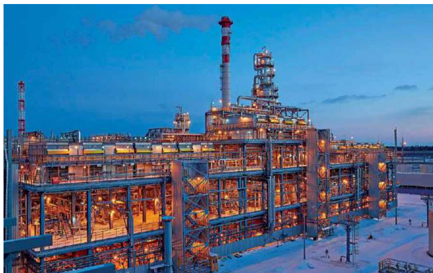
Фото 3. Для защиты от коррозии на Антипинском НПЗ использовались материалы ВМП
